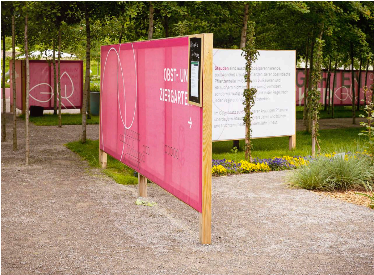
Bundesgartenschau (Saksan liittovaltion puutarhanäyttely) 2019 Heilbronn: osastoaidat asennettu FERRADIX® Country-ankureilla
