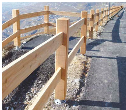
Wallisin kantoni: puukaiteet asennettu FERRADIX® Alpha -ankkurilla (lisävarusteena "GOTHIC" -puutoppakiinnikkeet)
